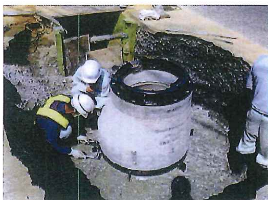
固定バンド設置
